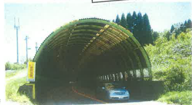
スノーシェッド 下り入口
