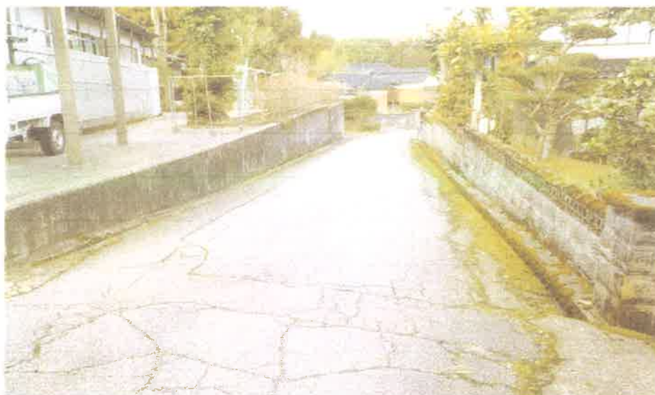
⑥市道論田瀬戸線の側溝改修拡幅（宅～）昨年同
